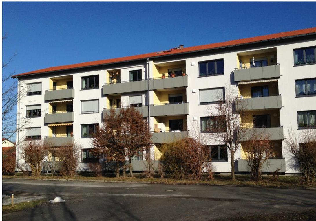
Das Mehrfamilienhaus mit 16 Wohneinheiten wurde 1971 errichtet und wies einen hohen Instandhaltungsrückstand auf. Im Zuge der ohnehin erforderlichen Instandsetzungsmaßnahmen (Fenster, Brandschutzmängel, etc.) wurde das Gebäude grundlegend saniert. Durch den Einbau neuer Fenster, dem Einbau eines mineralischen Wärmedämmverbundsystems und den Einbau dezentraler Lüftungsgeräte mit Wärmerückgewinnung erfüllt das Gebäude die Anforderungen eines Energieeffizienzhauses „Kfw-100“.
