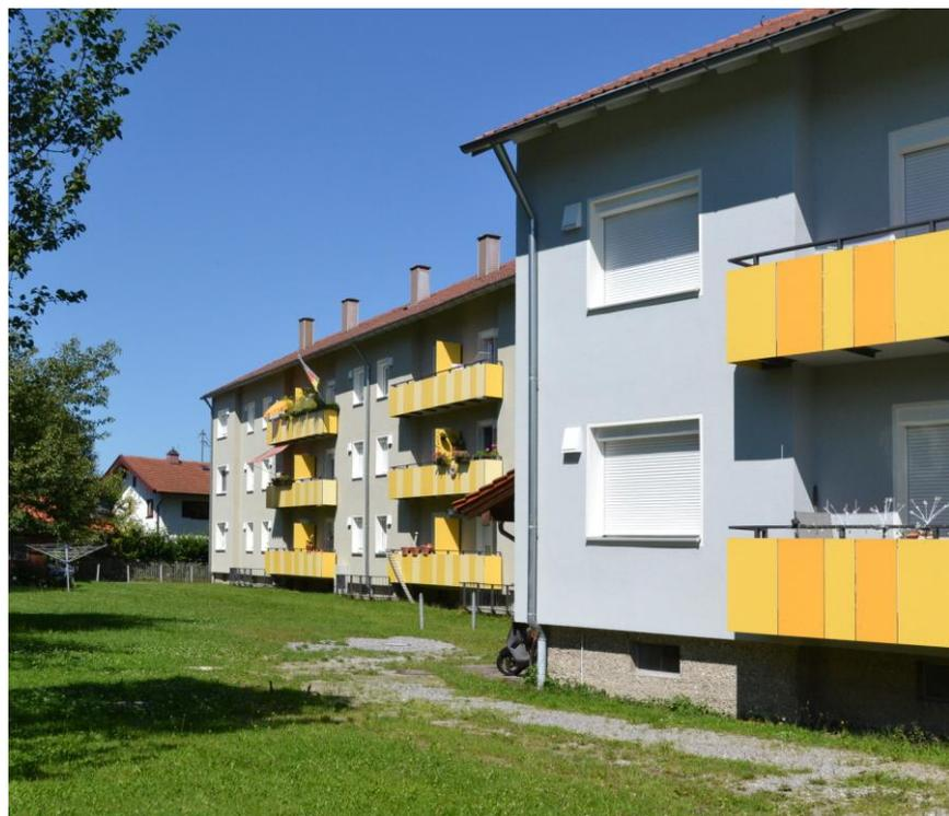
Die Wohnanlage aus einem größeren Mehrfamilienhaus mit 18 Wohneinheiten und einem kleineren Mehrfamilienhaus mit 10 Wohneinheiten wurde 1955 errichtet. Die beiden Wohnblöcke wurden energetisch saniert. Alle Wohnungen wurden mit dezentralen Lüftungsgeräten mit Wärmerückgewinnung ausgestattet. 2016 wurden die Außenanlagen erneuert und die Stellplätze neu angelegt. Die Heizkosten konnten damit nachweislich um 40% gesenkt werden.
