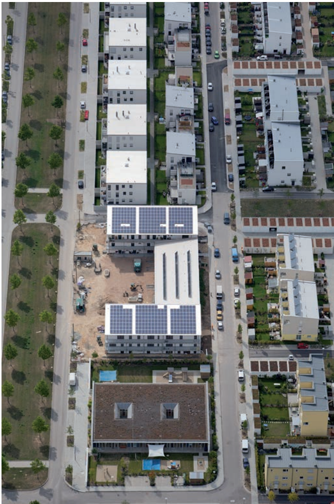
Bild 6. Eine großflächige PV-Anlage zur Stromerzeugung wurde auf den Dächern des Ost- und Westflügels installiert
